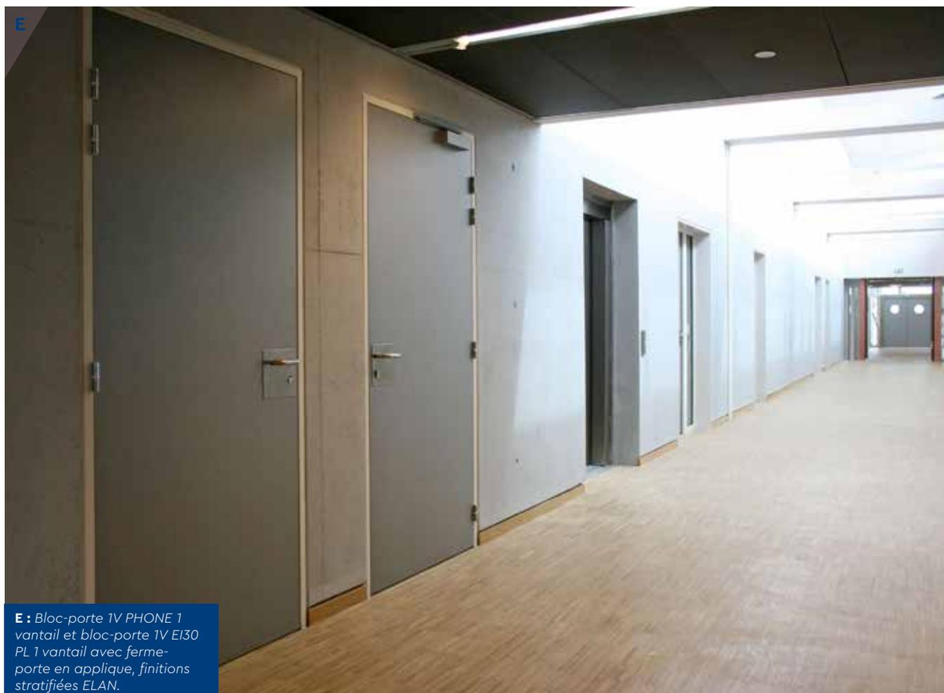
**E :** Bloc-porte 1V PHONE 1 vantail et bloc-porte 1V EI30 PL 1 vantail avec ferme-porte en applique, finitions stratifiées ELAN.
