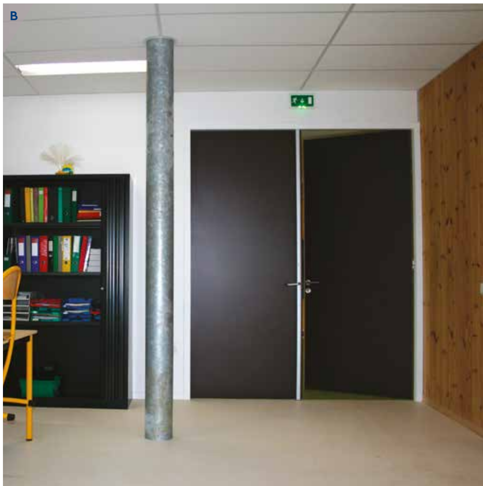
A : Bloc-porte 2V UNIPHONE 2 vantaux inégaux, finition stratifiés ELAN, avec châssis vitré adjacent B : Bloc-porte 2V UNIPHONE 2 vantaux égaux grande hauteur, finition stratifiés ELAN avec crémone en applique C : Bloc-porte 2V UNIPHONE 2 vantaux égaux grande hauteur, finition stratifiés ELAN
