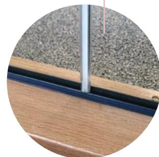
Pour un rendu esthétique harmonieux et équilibré, les vitrages d'une cloison vitrée sont de même largeur (largeur maxi 1050 mm par vitrage) et le joint vertical inter-module est en silicone translucide.
